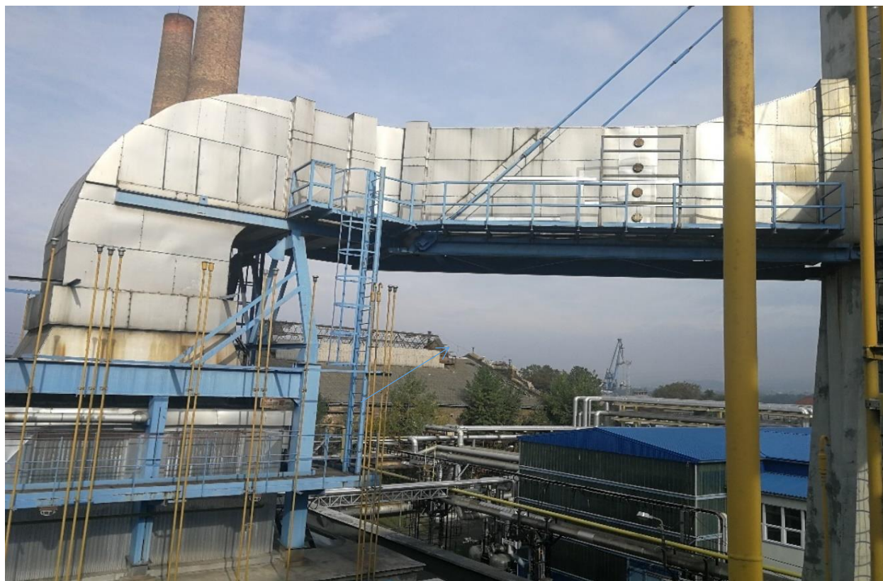
36. ábra: Füstgázcsatorna (jelenlegi állapot)
