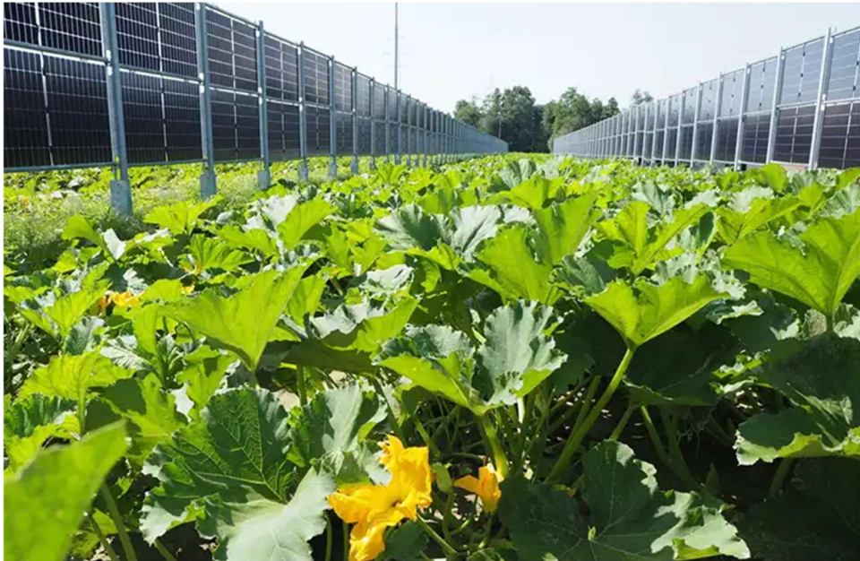
15. ábra. Vertikálisan elhelyezett bifaciális panelekből álló napelemez rendszer Gabersdorfban (Kép forrása: https://next2sun.com/en/next2sun-and-tep-renewables-push-agri-pv-expansion-in-the-uk-2/ ) (19)
