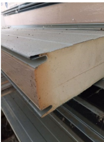
6. ábra: A szendvicspanel
