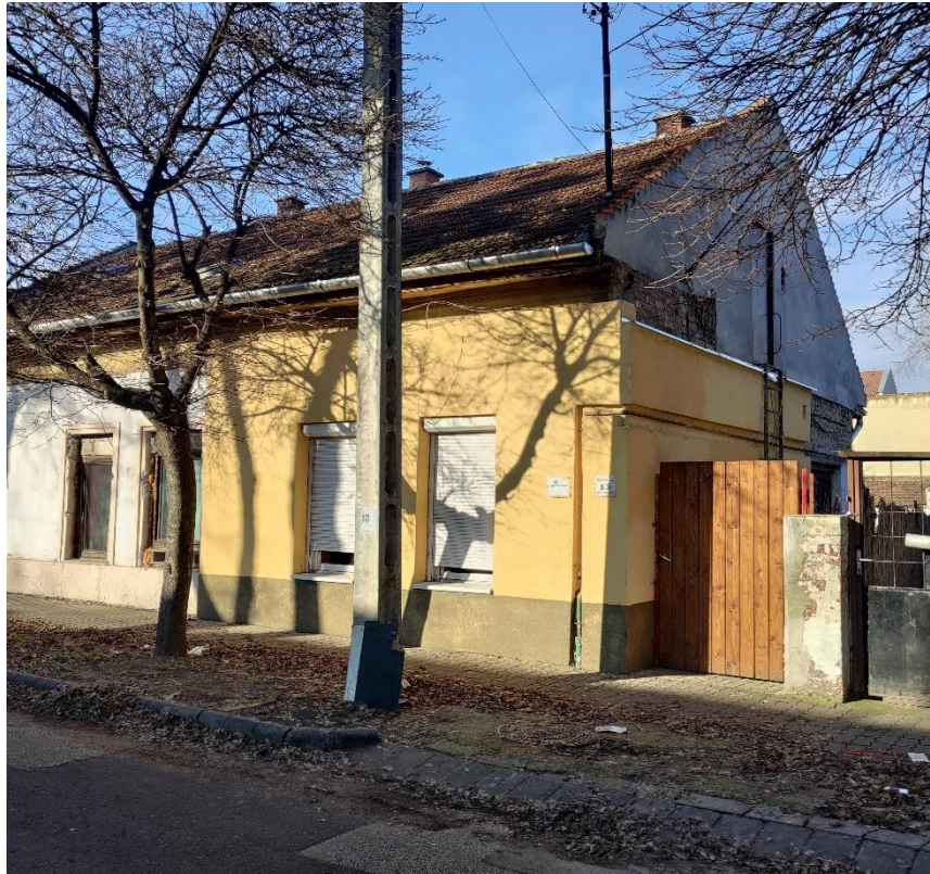
31. ábra A részben megújult homlokzati rész (saját fotó)
