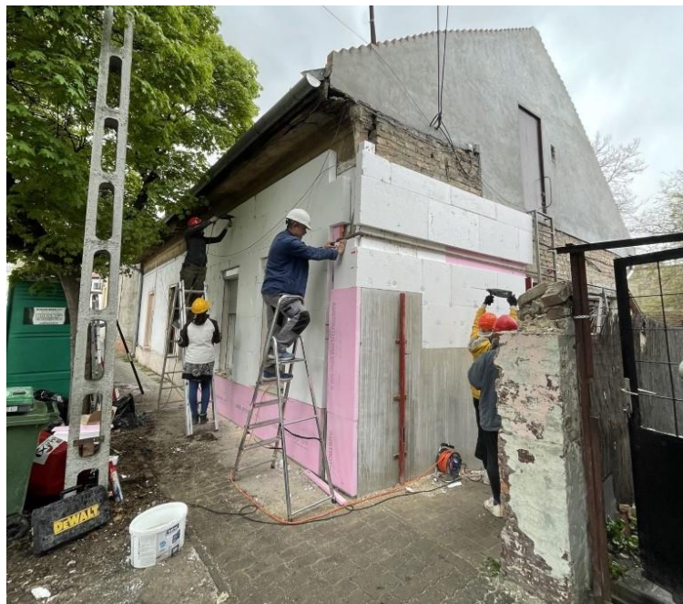
25. ábra Utólagos hőszigetelés került az épületrészre (forrás: ULE - saját fotó)
