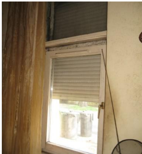
26. ábra Félig felújított ablak légbevezetővel (forrás: saját fotó)
