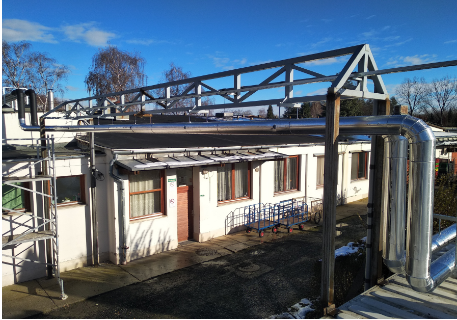
19.ábra távvezeték kiépítése Saját fotó
