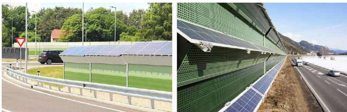
25. ábra Utólag zajfalra felhelyezhető napelemes egységek az ausztriai Forster cégcsoport kivitelezésében (Forrás: https://www.forster.at/silent-solar )
