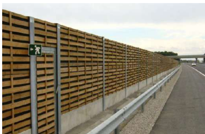
3. ábra Fafonatos zajárnyékolófal (Forrás: https://asalehu.unionjill.org/content?c=zajv%C3%A9d%C5%91+ker%C3%ADt%C3%A9s&id=40 )
