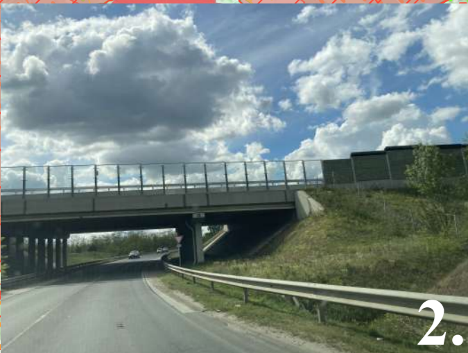
2. M0 körgyűrű Pécelnél a felüljáró alulról fotózva (Saját kép: 2024.04.21)
