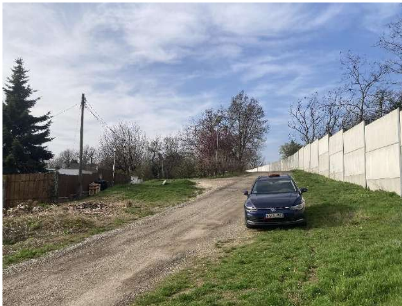
7. ábra Fabeton zajfal a védendő oldal felől, Érd, M7 (Forrás: Saját kép, 2024.03.14)
