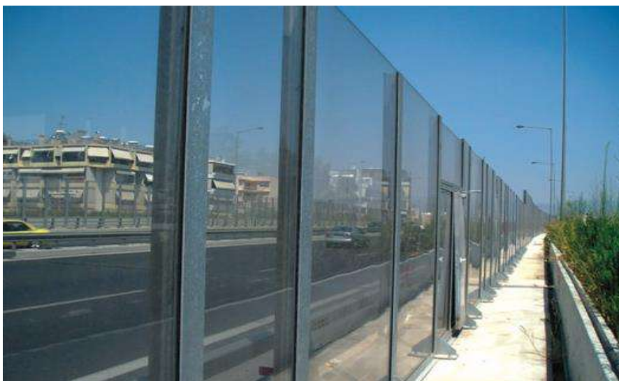
5. ábra Üvegből készült zajárnyékolófal (Forrás: https://alphacoustic.com/en/product/transparent-noise-barrier/ )
