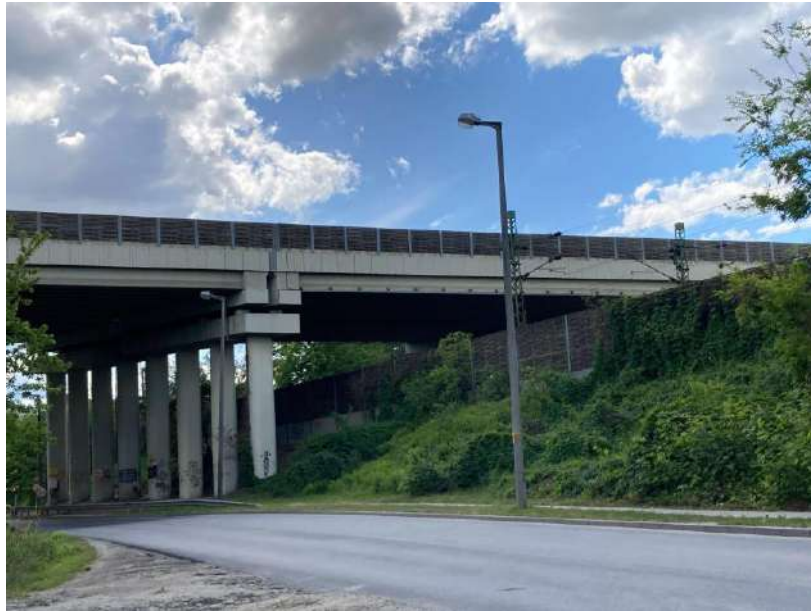
18. ábra M0 körgyűrű Dunakeszinét a felüljáró alulról fotózva (Saját kép: 2024.04.21)
