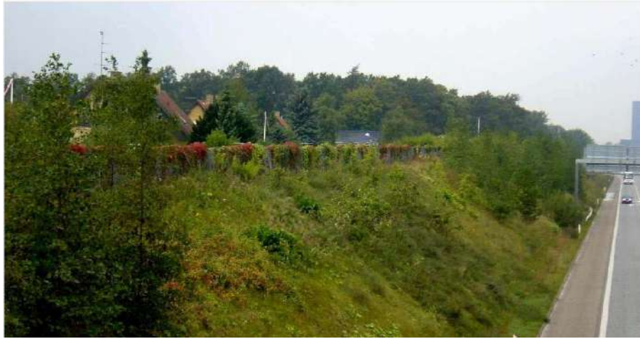
23. ábra Növénnyel telepített zajvédelmi töltés Németországban (Forrás https://www.semanticscholar.org/paper/Noise-Barrier-Design-Danish-and-some-European-Bendtsen/e98493940ab7f8ec89cafde97720af7f8f62bca3/figure/41 )
