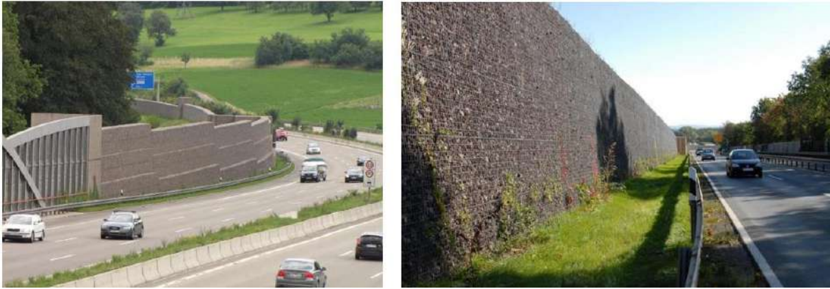
8. ábra Gabionfalak, Sinsheim, BAB 6 és Sarstedt, B 6 Németország (Forrás: https://hoy-geokunststoffe.de/referenzen/ )
