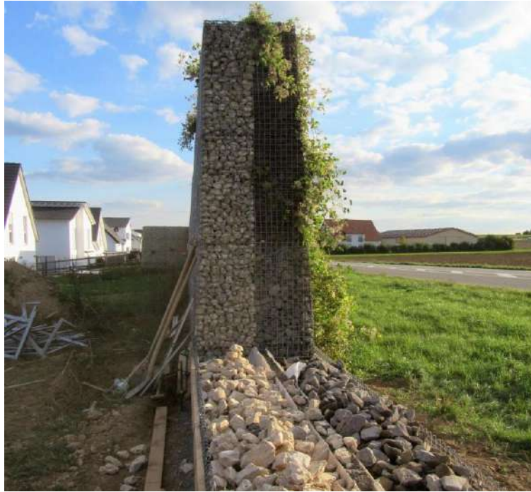
9. ábra Gabionfal kitöltése különböző anyagokkal (Forrás: https://hoy-geokunststoffe.de/laermschutz-mit-gabionen/ )
