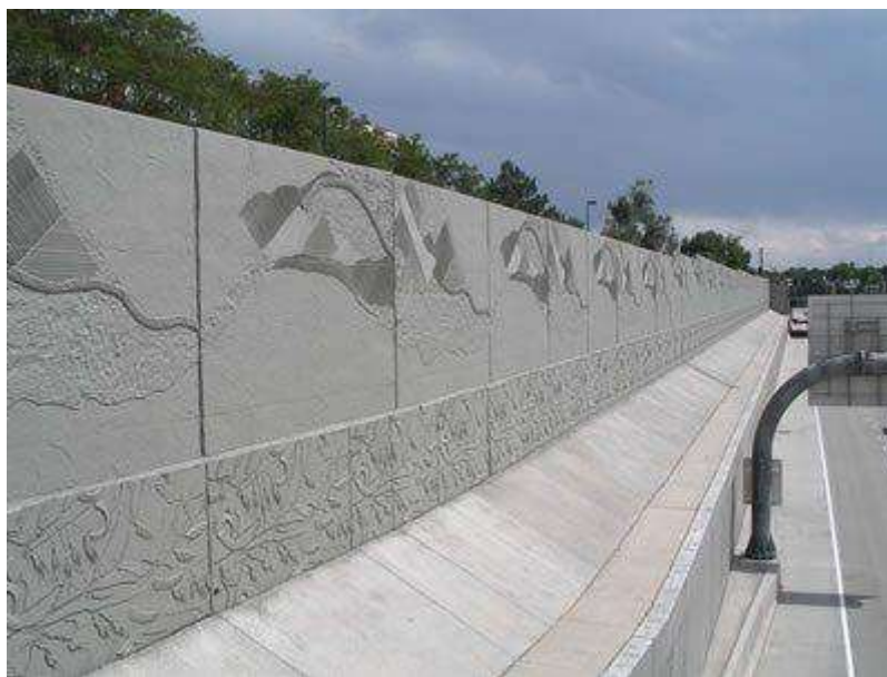
2. ábra Zajfal betonból mintázattal (forrás: https://www.concretenetwork.com/photo-gallery/site_26/photo_7054/ )
