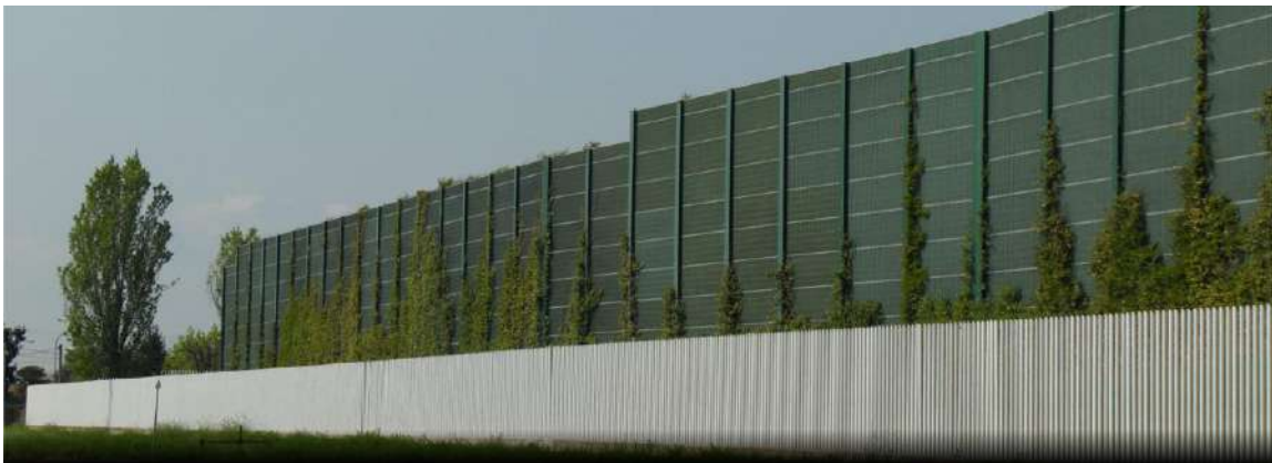
24. ábra Növényvel felfuttatott zajárnyékoló fal KOHLHAUER cégcsoport kivitelezésében (Forrás: https://www.kohlhauer.com/planta/ )
