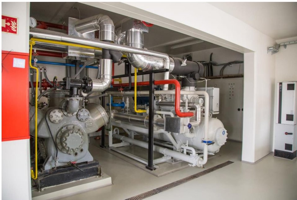
13. ábra Mayekawa-Mycom N220JL –VE iker csavarkompresszor (Forrás: saját kép)
