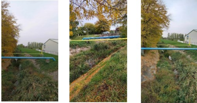
3. kép Benta-patak feletti közművezetékek
