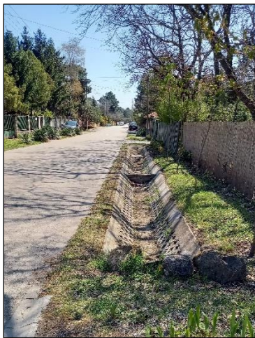
8. kép Vízvezetés a Földmunkás utca első 150m-én
