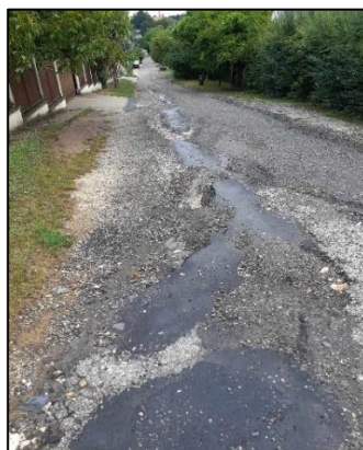
7. kép Vízvezetés hiánya- Iparos utca (fő gyűjtőút) kavics lemosódás kisebb eső után, illetve burkolt és burkolatlan utcák csapadékvíz eróziója (Fotó: Kovács Fanni, 2023.)
