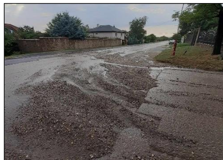
6. kép Csapadékvíz elvezetésének hiánya (Fotó: Kovács Fanni 2023.)
