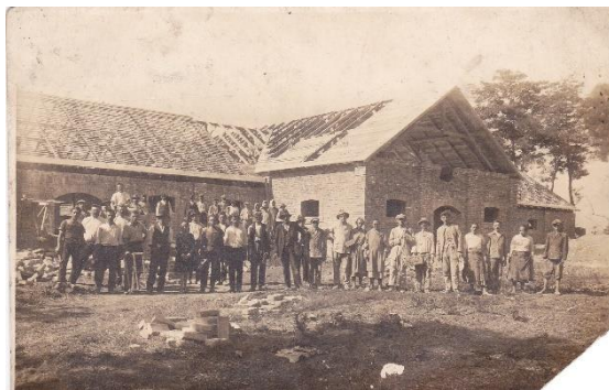
48. ábra: Vadvirág vendéglő építés közben Forrás: http15
