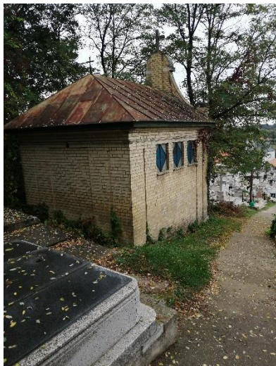
35. ábra: Kripta kívülről Saját fénykép
