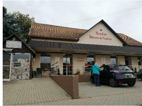
47. ábra: Korona Szálloda és Vendéglő épülete most Saját fénykép
