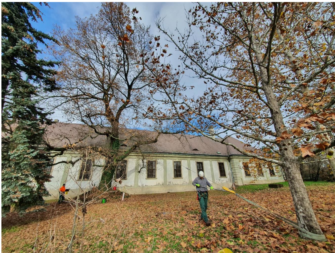
11. ábra. Műemléki védettségű, történeti kertben álló, a műemléki épületet veszélyeztető fa húzóvizsgálata. (forrás: saját felvétel, 2022).
