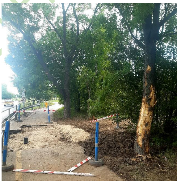
6. ábra. Vízcsőtörés elhárítás üzemzavarban. A fa a beavatkozástól legalább öt méterre állt, mégis súlyos sérüléseket szenvedett. (forrás: Szabó Gellért Vilmos felvétele 2021.)
