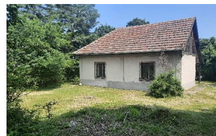
22.ábra Elhagyott romos épület (forrás: saját fénykép)
