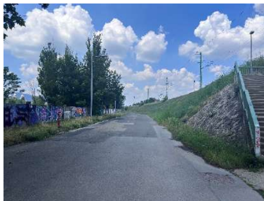
14. ábra: Járda nélküli útszakaszok a Gázgyár mentén (Gázgyár utca) (saját fénykép, 2023)
