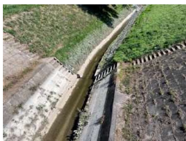
41. ábra: Az Aranyhegyi-patak kiépített medre (saját fénykép, 2023)
