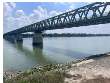
40. ábra: Az Újpesti vasúti híd (saját fénykép, 2023)
