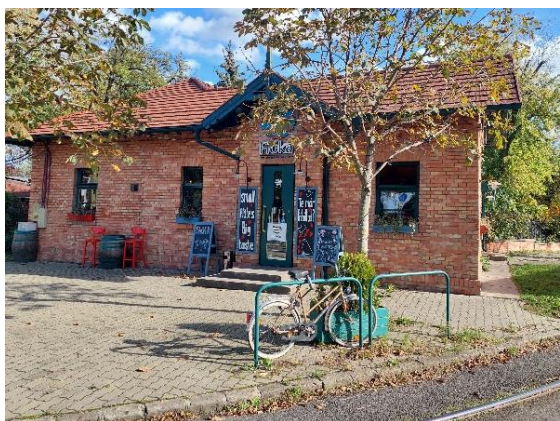
37.ábra: FIÓKA Étterem védett épülete (Saját készítésű fotó)
