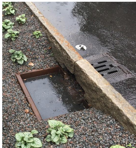
15.ábra: Ülepítő működés közben, Uppsala, Svédország (Forrás: THYNELL2018)
