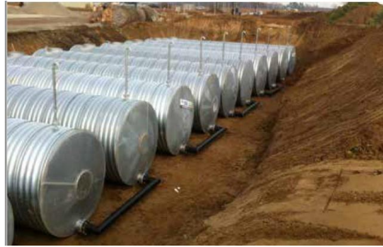
14.ábra: Földalatti víztározó tartályok (Forrás: ZIF2018_3)
