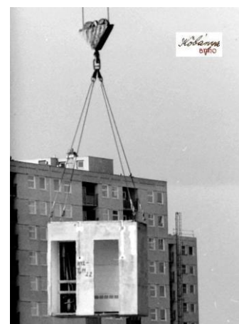
4. ábra: Pillanatkép az építés munkálataiból
