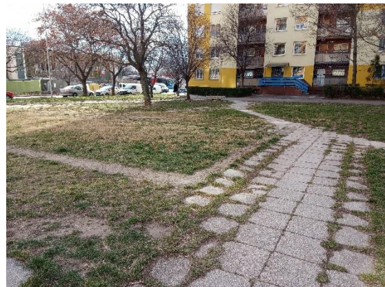
10. ábra: Beton járdalap burkolat
