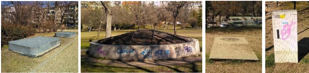
VII. ábra: Jelenlegi állapot – közművek, aknák (saját fotók) (előbb)
