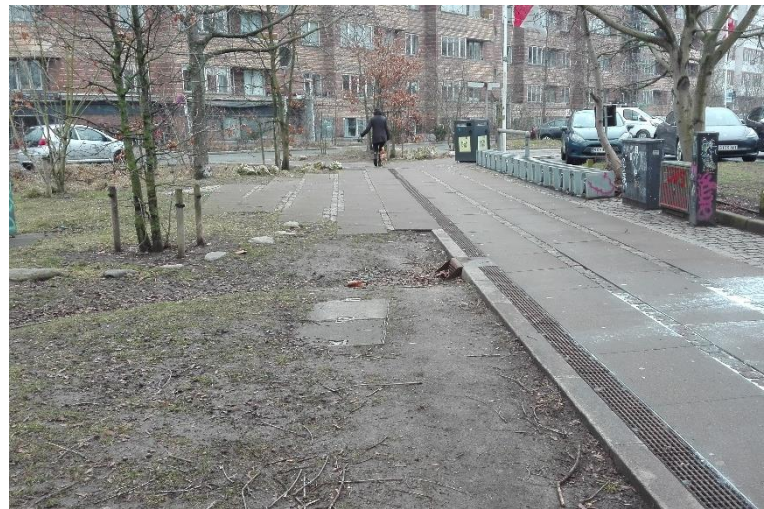
4. melléklet: Skt. Kjelds Plads, vízcsatornák, túlfolyók (Forrás: Saját fényképek, 2023)
