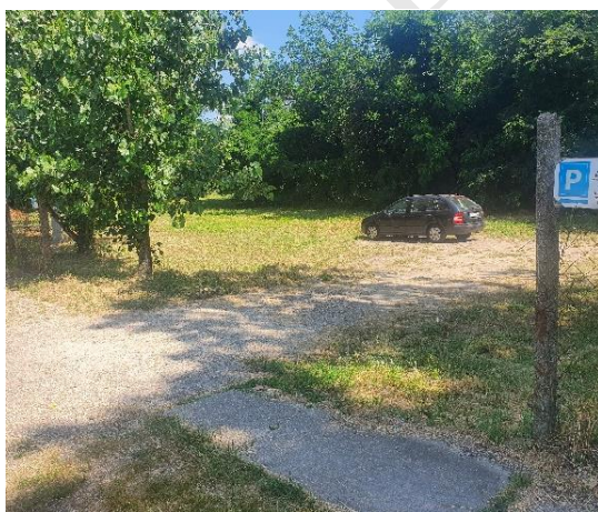
45. Melléklet: Megbontott kerítés (saját kép)
