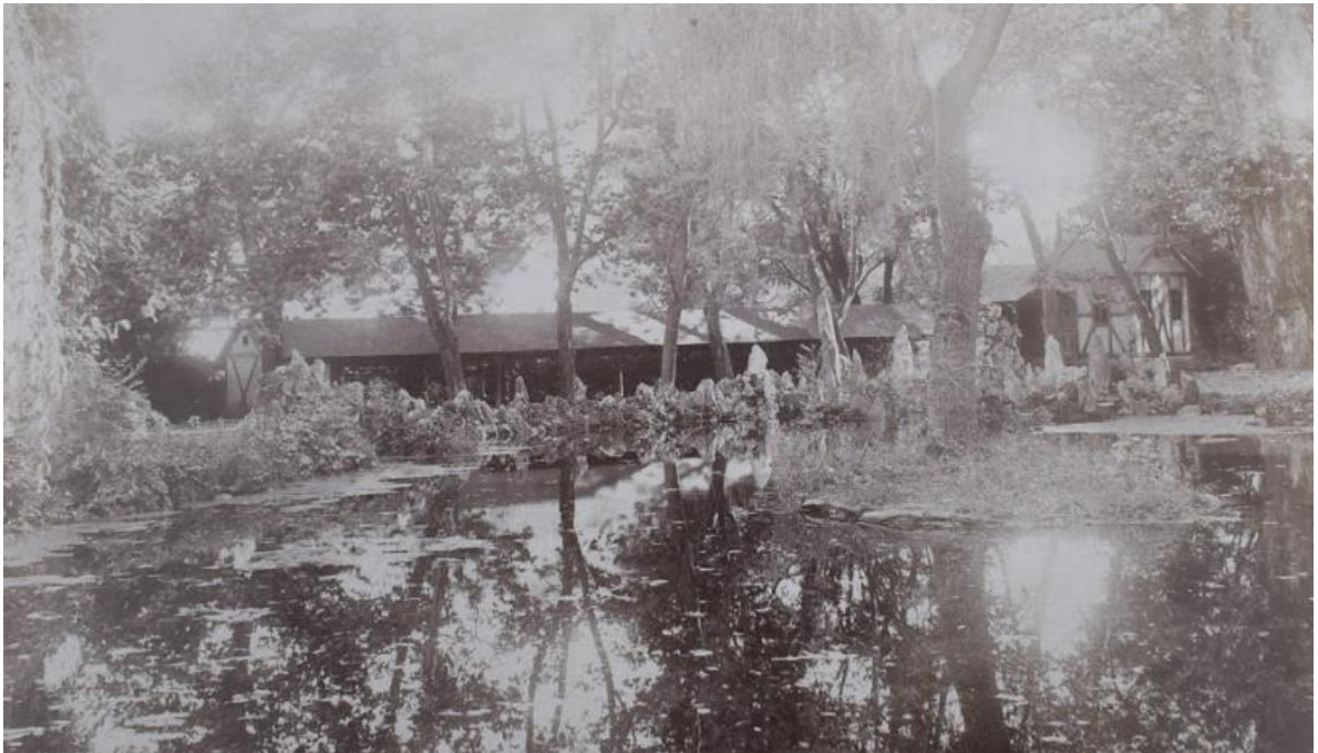
12/a. Kerti tó szigettel a közepén. Háttérben a tekepálya (hosszú épület) és törpelak („Fachwerk” szerkezetű házikó) A tó és az épületek között sziklakert volt. (Forrás: Sandru Vasile Cornel személyes archívuma, a pontos datálás nem ismert)
