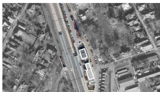
7. ábra Isaszeg vasútállomás a korszerűsítés után Forrás: saját ábra (felhasznált térkép: Google Satellite 2022 (Google Earth Pro))
