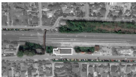
2. ábra Pécel vasútállomás a korszerűsítés előtt Forrás: saját ábra (felhasznált térkép: Google Satellite 2018 (Google Earth Pro))
