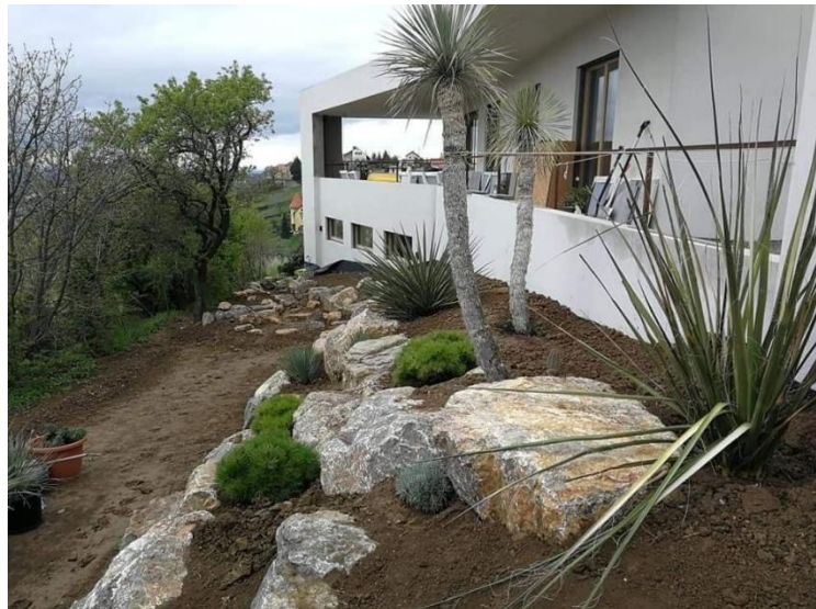
47. ábra Támfalként funkcionáló sziklakert építésének kezdeti fázisa, Kiss József munkája. Forrás: Kiss József
