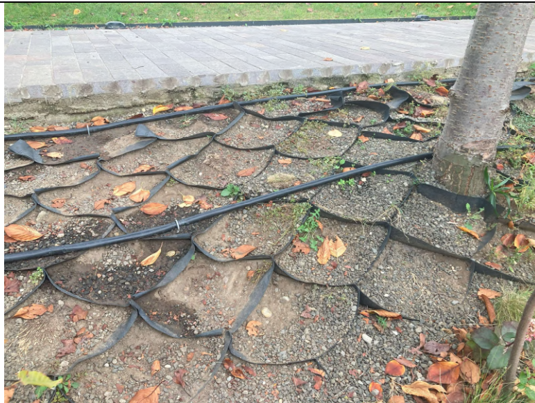
59. ábra – A 4-es terület őszi állapota és az elcsúszott csepegtetőcső, 2023.09.30.
