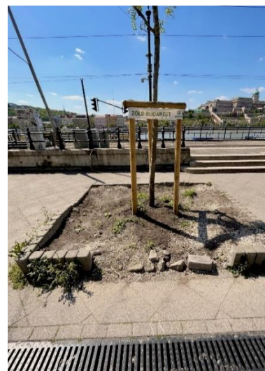
26. ábra Erősen degradált fahely
