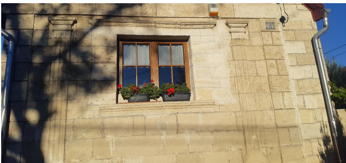
31.ábra: Durva mészkő megjelenése az épületen és díszítés, Sósút Kossuth Lajos utca forrás: Saját kép
