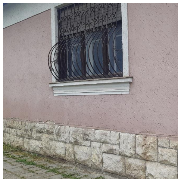
29.ábra: Durva mészkő megjelenése a lábazaton, Érd Alsó utca forrás: Saját kép
