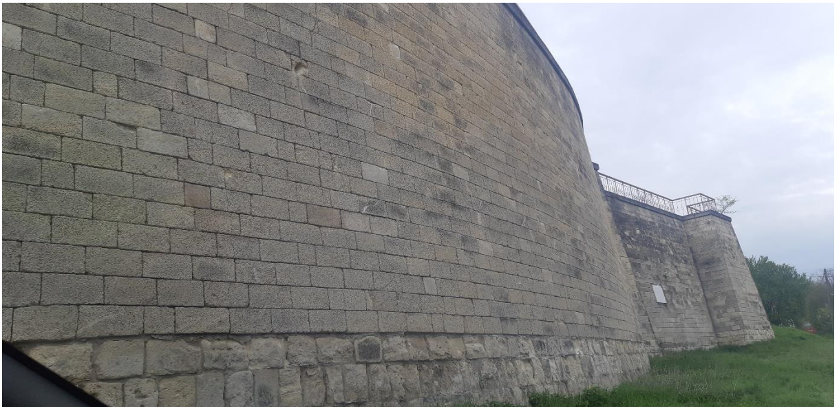
58.ábra: Szapáry kastély támfala durva mészkőből Érd Ófalu forrás: Saját kép
