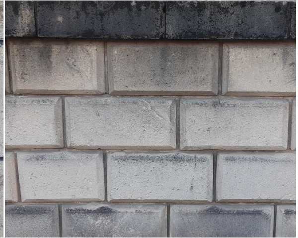
40.ábra: Durva mészkő falazat magas megmunkáltságú azonos méretű kövekből habarcs fugával forrás: Saját kép
