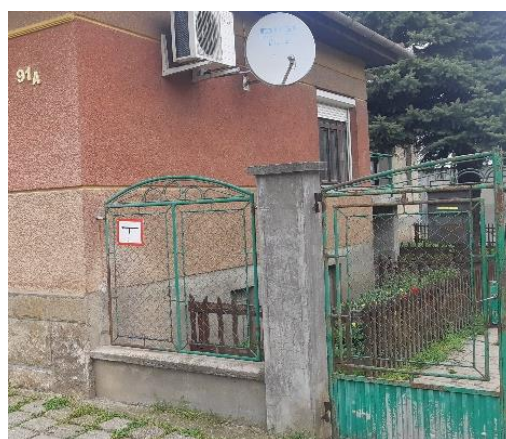
17.ábra: Beton és fém kerítés, forrás: Saját fénykép
