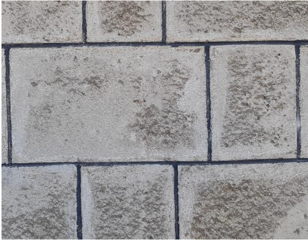
39.ábra: Durva mészkő falazat változó nagyságú kövekből bitumenes fugával forrás: Saját kép
