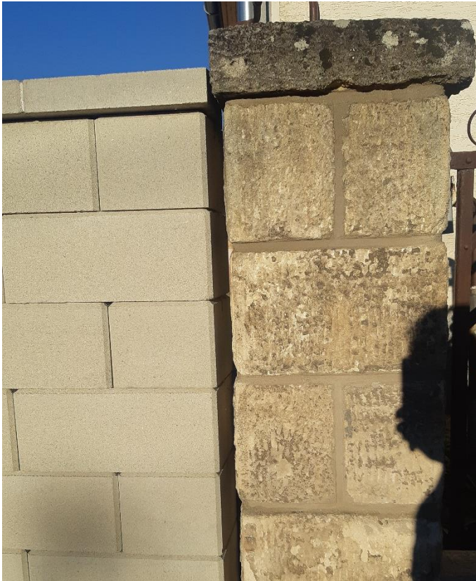
62.ábra: Durva mészkő kerítés és beton elemes kerítés találkozása Sósút forrás: Saját kép
