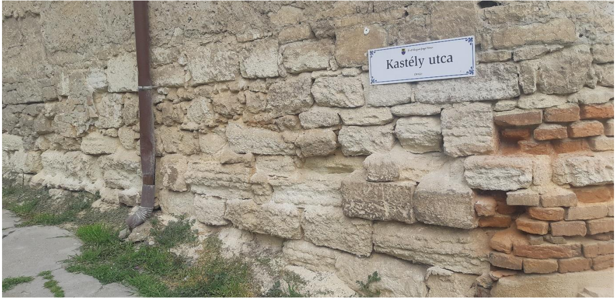
61.ábra: Durva mészkő és téglá vegyes falazat leromlott állapot Érd Kastély utca forrás: Saját kép
