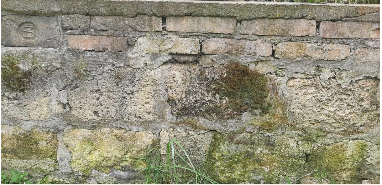
57.ábra: Durva mészkő és téglavegyes falazat beton fedéssel Érd Mély út forrás: Saját kép
