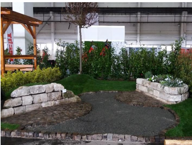
47.ábra: Durva mészkő szárazon rakott támfal és íves magaságyás forrás: X. Magyar Kertépítő verseny 2018
