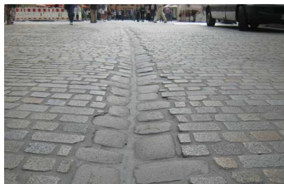
20. ábra Nyílt terméskő vápa (forrás: Zöldinfrastruktúra Füzetek 3.)
