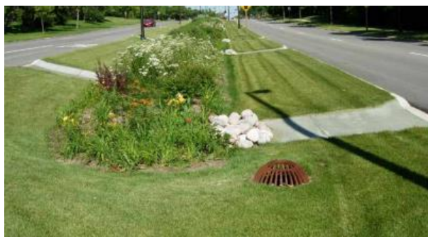
26. ábra Szűrőárok (forrás: Zöldinfrastruktúra Füzetek 3.)
