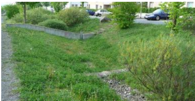
25. ábra Drénezett szikkasztóárok (forrás: Zöldinfrastruktúra Füzetek 3.)
