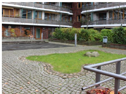
19. ábra Vízáteresztő burkolatok (forrás: Zöldinfrastruktúra Füzetek 5.)
