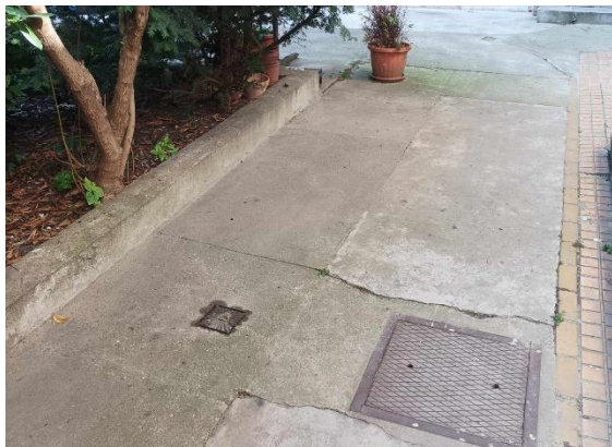
25. Melléklet Víznyelő akna a növénykazetta mellett (Saját fotó)
