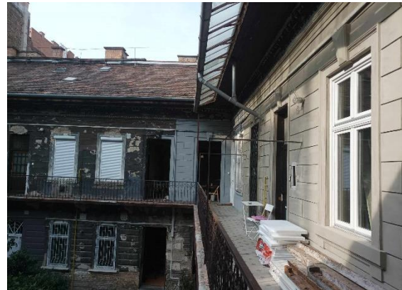
24. Melléklet Ereszcsatorna a bejárat felöli oldalon (Saját fotó)
