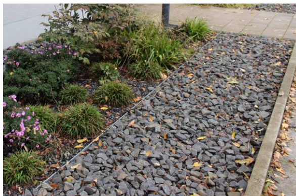
24. ábra Drénárok (forrás: Zöldinfrastruktúra Füzetek 3.)
