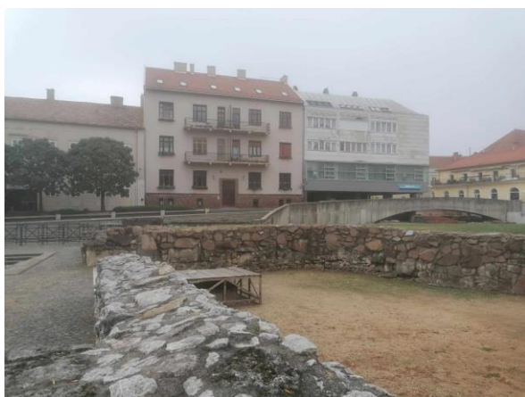
5. melléklet: Romterületre rányúló épület (jobbra) Saját fotó, 2023. 10. 15.
