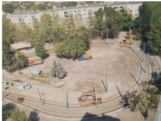
3. ábra: A kecskési delta-, és a tarjáni hurokforduló építése 2005-ben (SZKT 2008)
