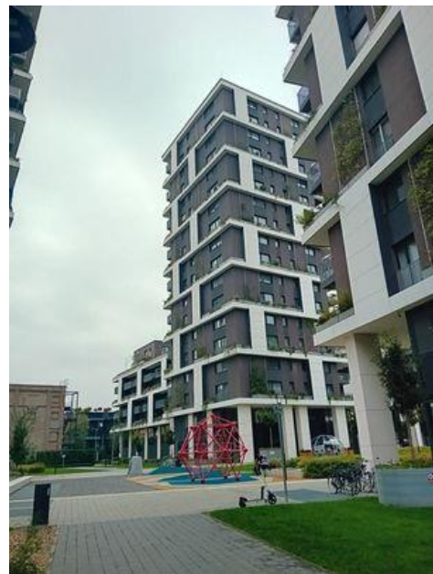
4. fénykép: Metrodom Panoráma épületegyüttese forrás: saját fotó
