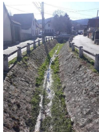
(75. ábra Patak jelenlegi állapota (alapadat forrása: saját fotó )
