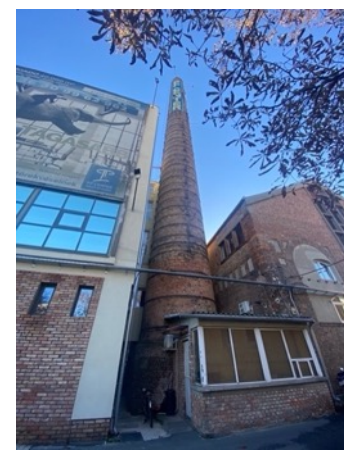
16. melléklet: Textilfestőgyár megmaradt kémény (Forrás: saját kép)
