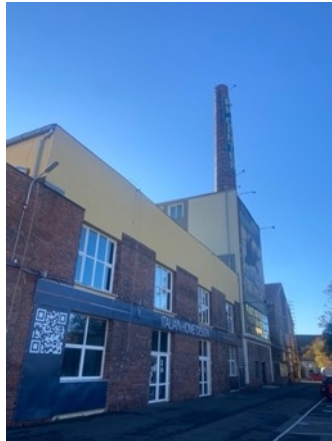
18. melléklet: Textilfestőgyár megmaradt homlokzat (Forrás: saját kép)
