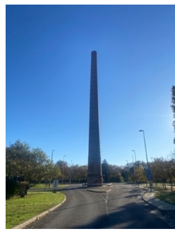
15. melléklet: Házgyár megmaradt kémény (Forrás: saját kép)
