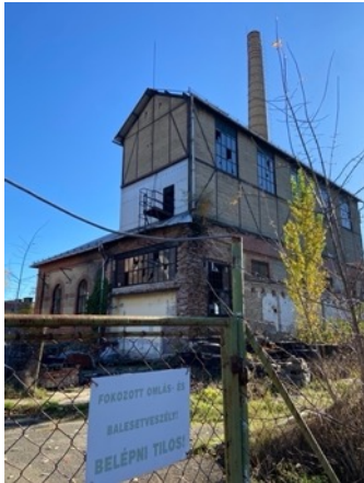
26. melléklet: Gázgyár elhagyatott épületek (Forrás: saját kép)
