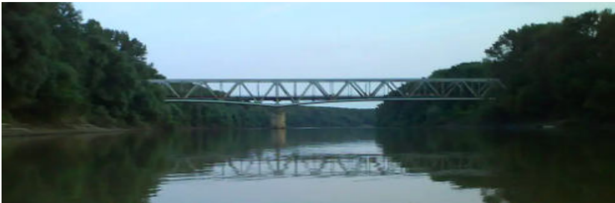
8.ábra: Szolnoki vasúti Tisza-híd (kép forrása: saját készítés)
