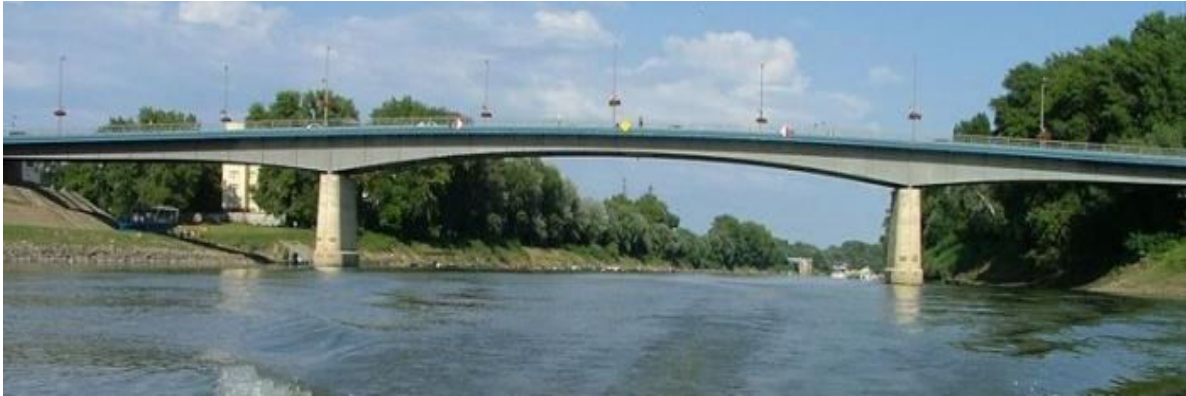
7.ábra:Szolnoki vasúti Tisza-híd
