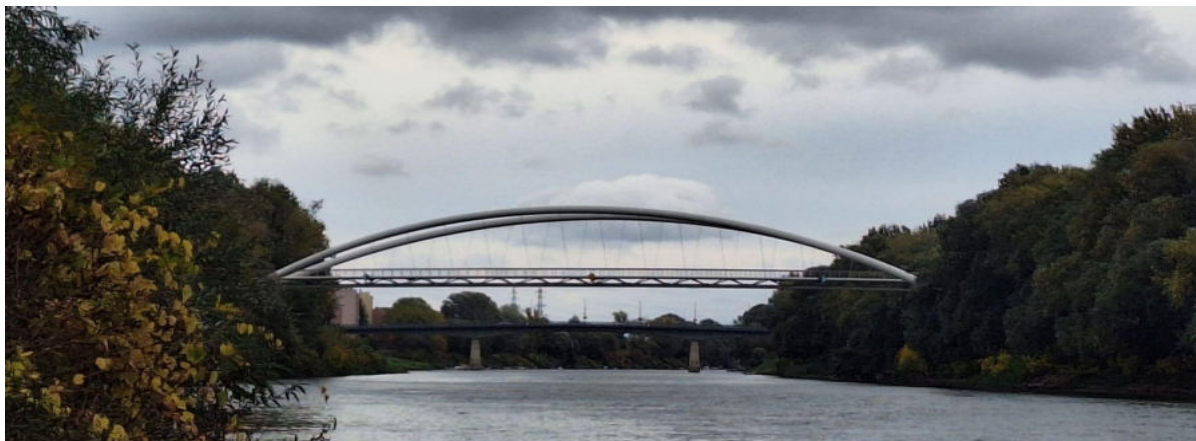
9.ábra: Tisza-híd (kép forrása: saját készítés)
