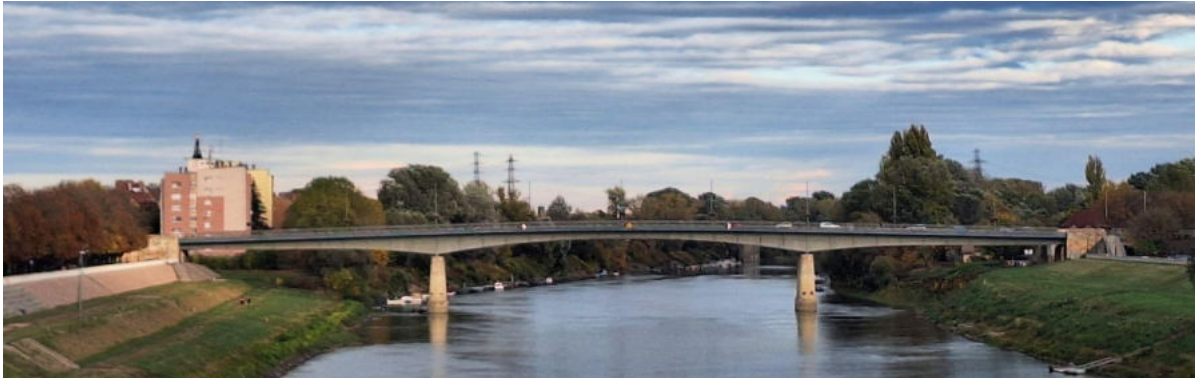
10.ábra: Tisza-híd (kép forrása: saját készítés)
