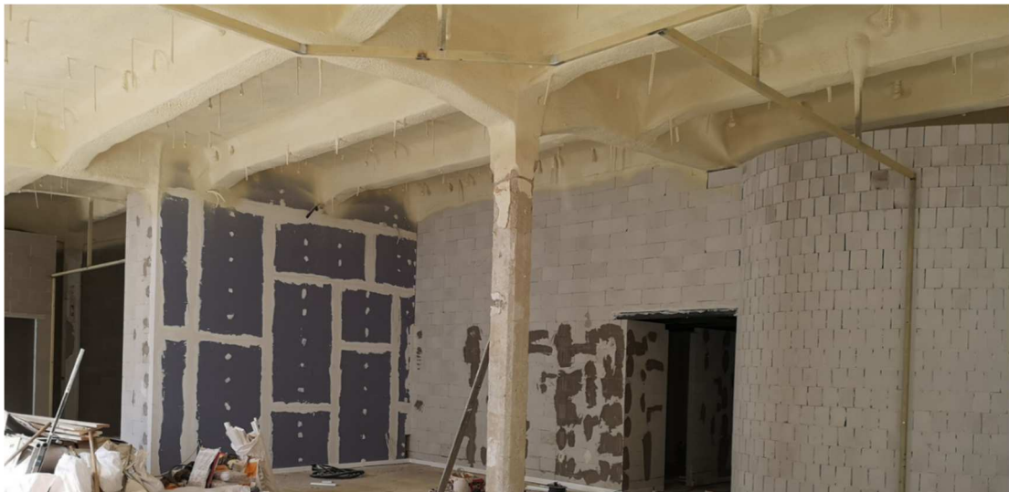
14. ábra Iroda a zártcellás szigetelés után a CEO irodarész felől
