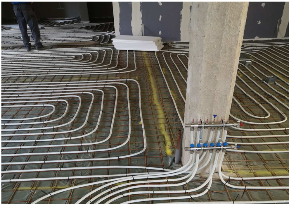
17. ábra Központi iroda oszlop osztója
