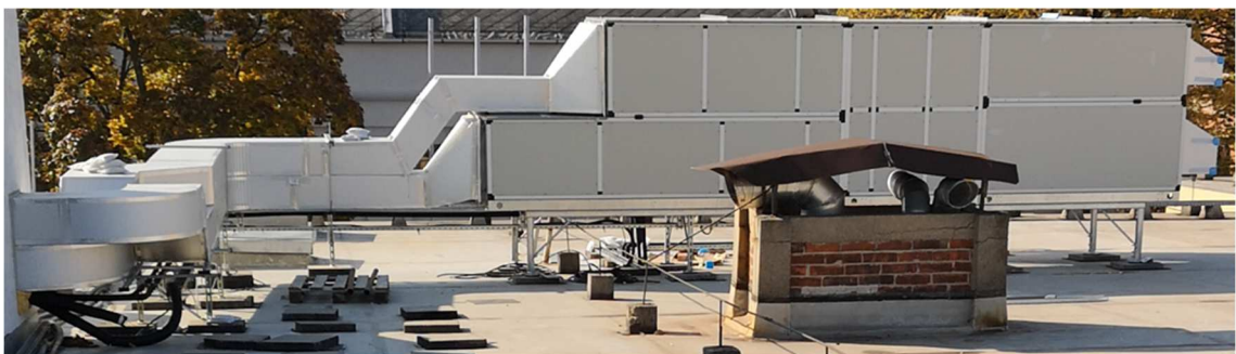
19. ábra MODIM Mérnöki Kft. légkezelője
