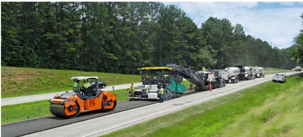
17. ábra Wirtgen W380 CR i hideg recycling géplánc (forrás: https://www.wirtgen-group.com )
