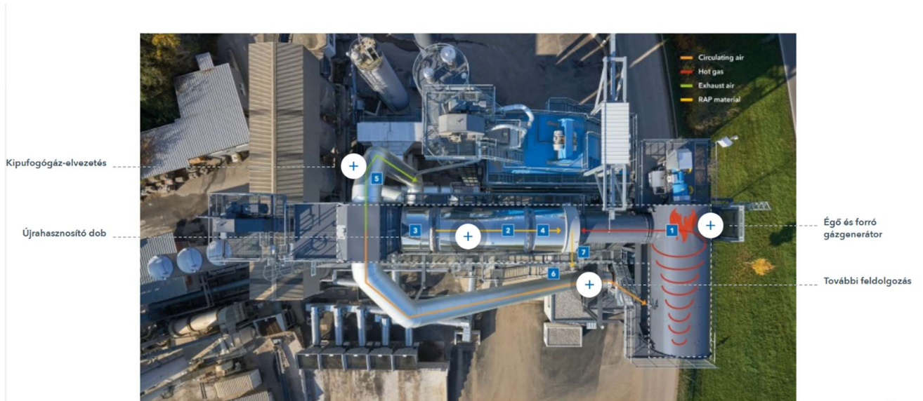
16. ábra Parallel dobos aszfalt keverő a maximális újrahasznosítás érdekében (forrás: https://www.wirtgen-group.com )
