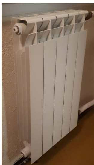
13. ábra: Alacsony előremenő víz hőmérsékletre igazított radiátor (Forrás: saját készítés)
