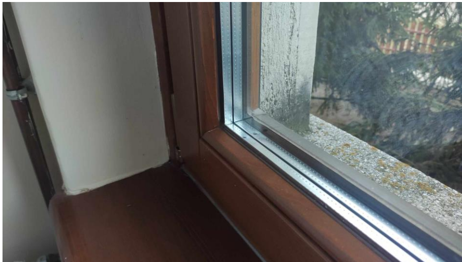
20. ábra: 3 rétegű nyílászáró (Forrás: saját ábra)
