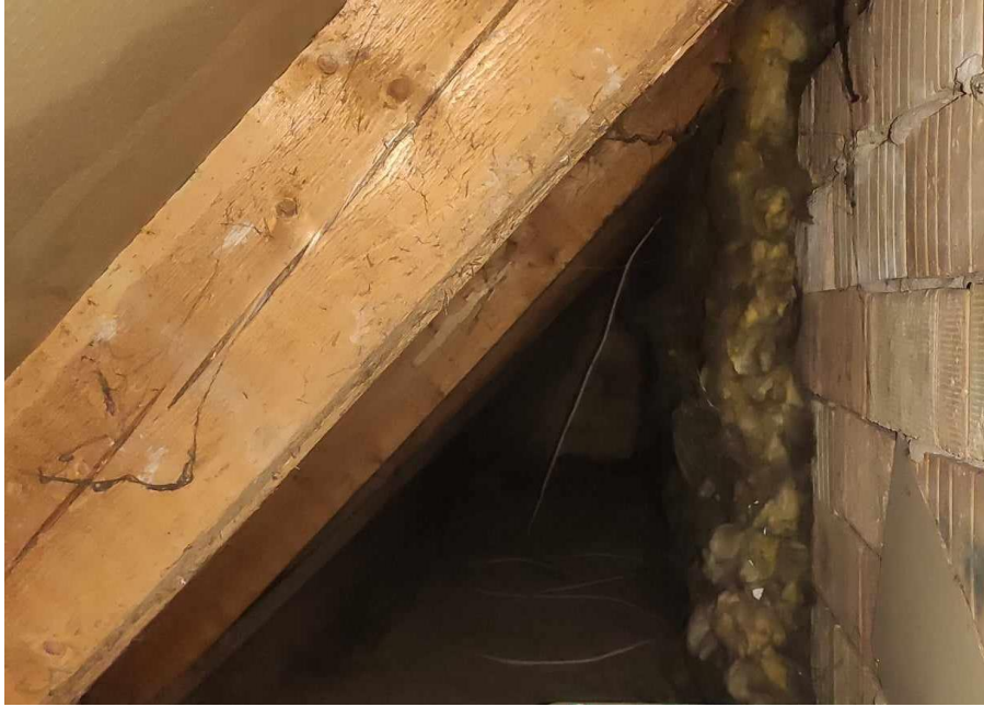
14. ábra: Búvótér részleges szigetelése (Forrás: saját ábra)
