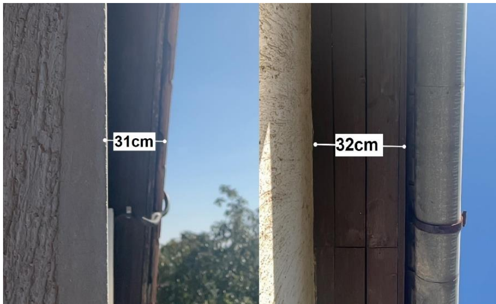
27. ábra: Szelemen és szarufa túlnyúlása (Forrás: saját ábra)
