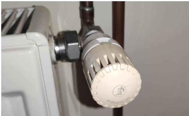
18. ábra: termosztatikus radiátorszelep (Forrás: saját ábra)
