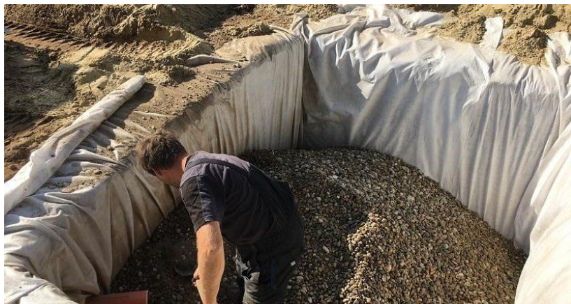
14. ábra Szikkasztó építése ( Esővízgyűjtés és szikkasztás, 2020 )
