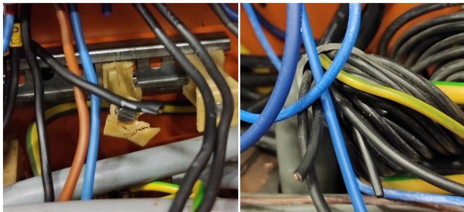
9. kép Bekötetlen, szabad vezetékek
