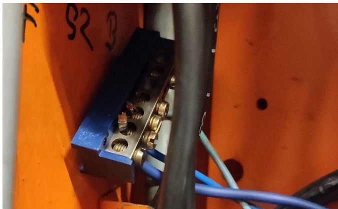
5. kép Rögzítetlen vezetősin
