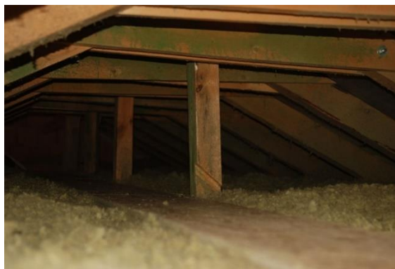
16. ábra fagyapottal szigetelt padlástér (fujszigetelések.hu 2023)
