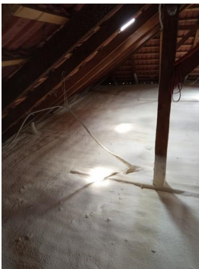
14. ábra poliuretán habbal szigetelt padlástér (fujtszigetelések.hu 2023)
