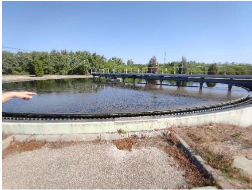
20. ábra: Dorr-típusú utóülepítő (Forrás: saját fotó)
