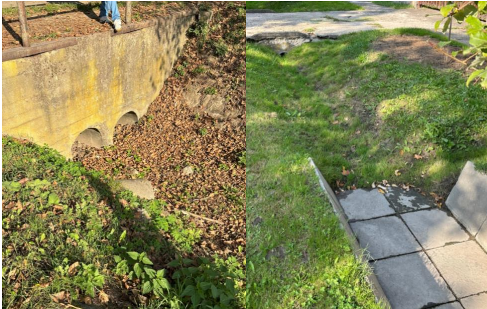
19. ábra: Példák az Ördög-árok problémái közül: bal oldalon a kiszáradt felső szakasz a Telki útnál, a jobb oldalon a hordalékkal teli meder figyelhető meg a Kolozsvár utcában (saját képek)
