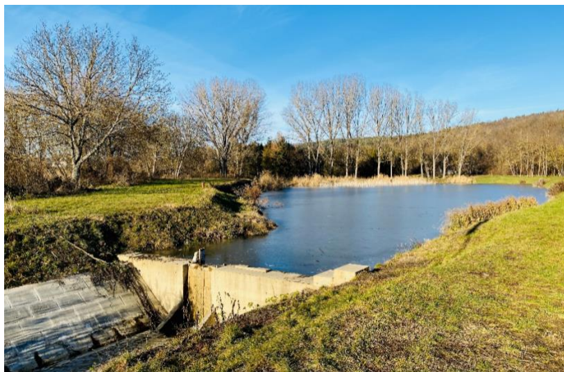
15. ábra: A püspökszilágyi oldalvíztározó (saját kép)
