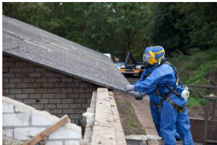
3. kép: Pala tető bontása (Forrás: lakásgeneral.com, 2022)
