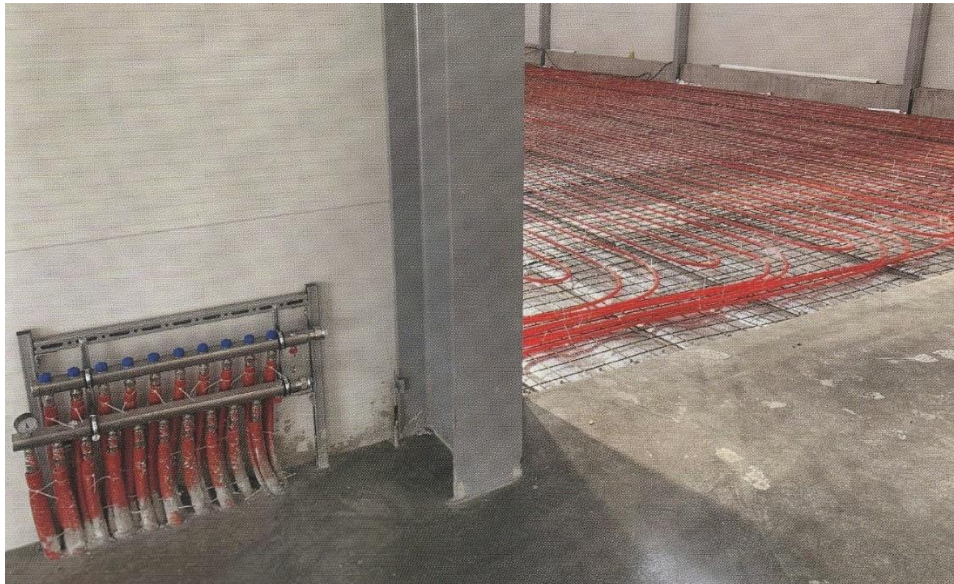
2. ábra Nedves padlófűtés esztrichben [KE KELIT prospektus]
