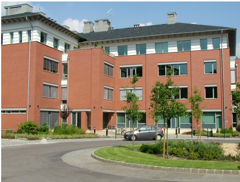
1. ábra Az irodaépület homlokzati képe (2023)
