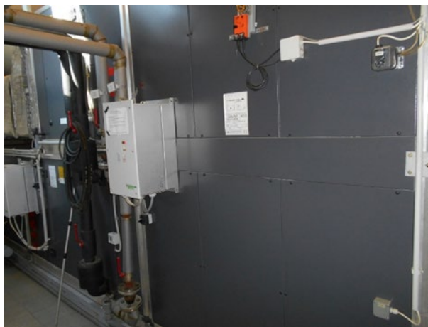
34. ábra CLIMACIAT GI 150 típusú légkezelő berendezés (2023)
