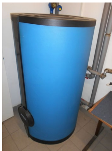
30. ábra Indirekt fűtésű HMV tároló (2023)
