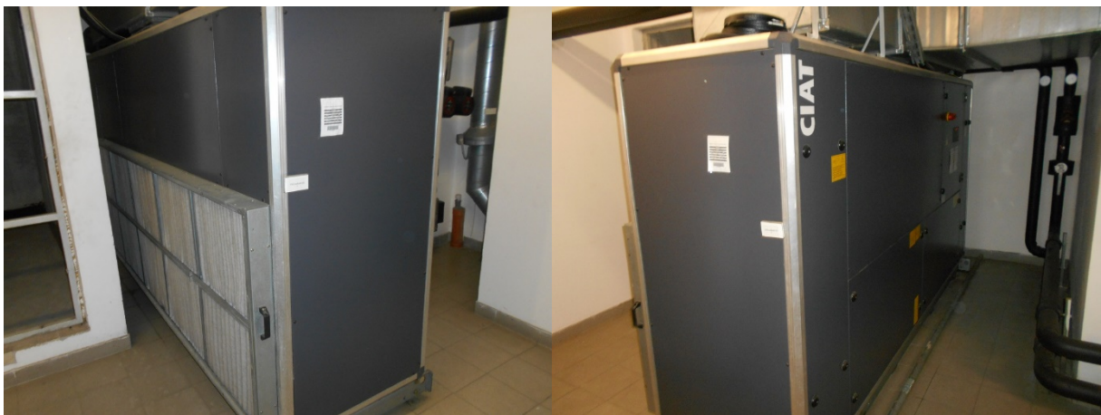
35. ábra CIATCOOLER LJA 600Z típusú folyadékűtő
