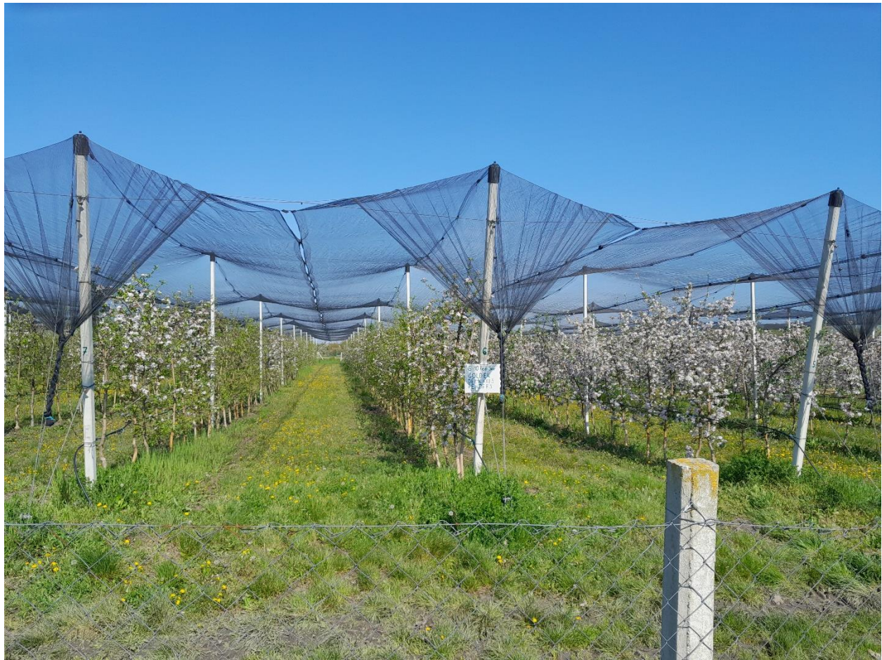
Jégvédelmi háló felállítása (saját felvétel 2023.04.28)
