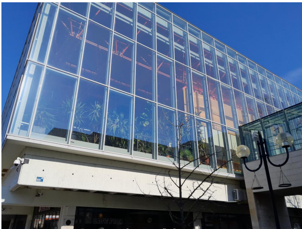
4. ábra: Az épület déli homlokzata, az újszerű függönyfallal, belső oldali árnyékolási rendszerrel
