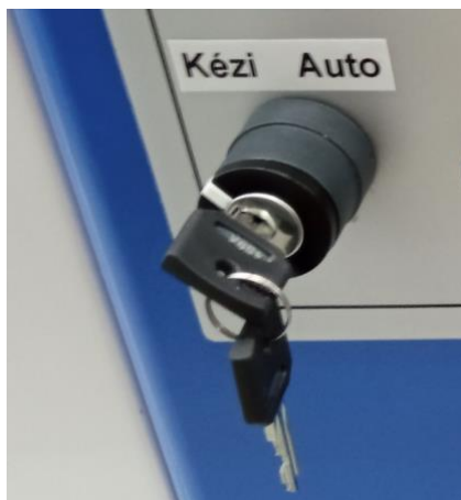
5. kép Schneider Electric ZB5AG2 kulcsos kapcsoló [forrás: saját]
