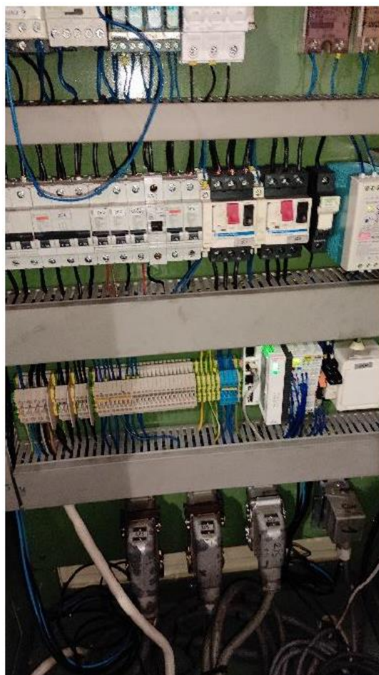
16. ábra Kónuszos excenter présgép villamos kapcsolószekrényének belseje (forrás: saját kép)
