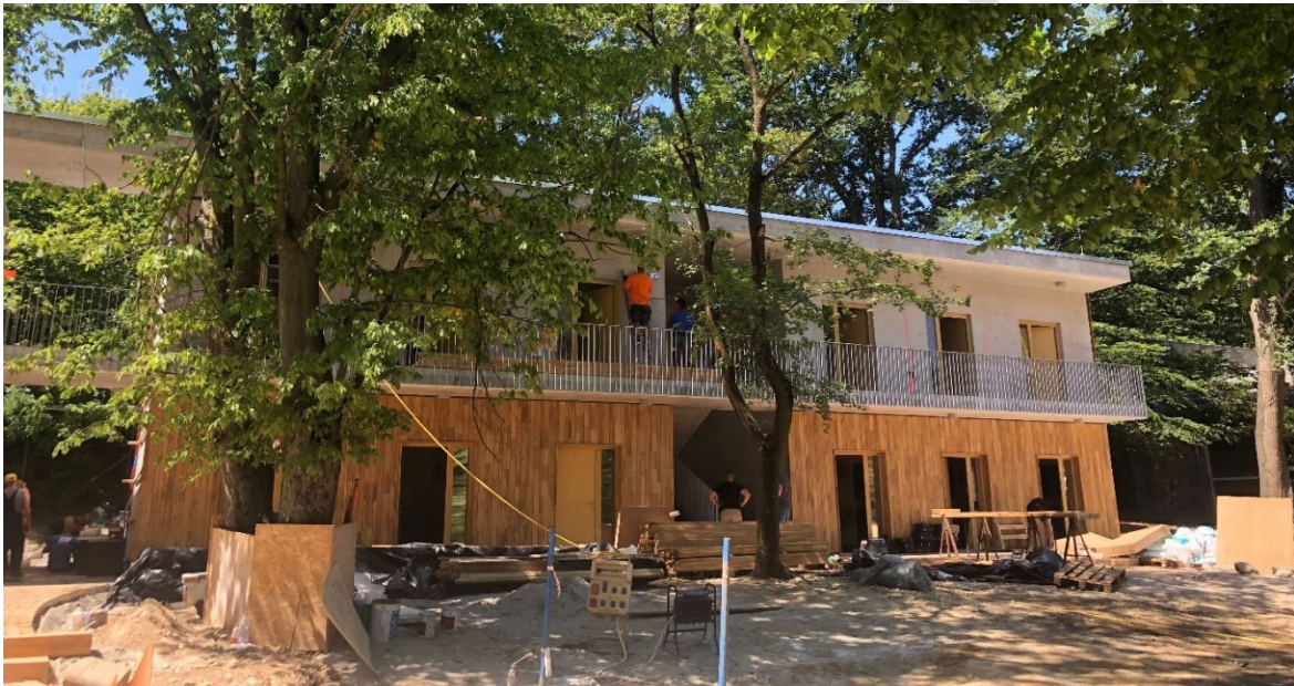
8. ábra: Fák törzsvédelme a kivitelezési munkák alatt (saját felvétel, 2022. június)
