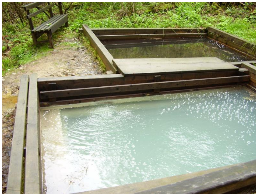
4. ábra: A Csiszár-fürdőn a különböző színű gyógyforrások (saját fotó)
