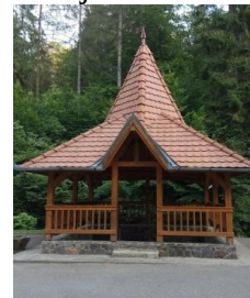
A felújított Erzsébet borvízforrás
